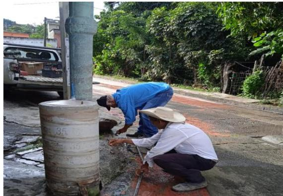
Reparación e instalación de válvulas en la red de agua potable, en las comunidades de Loma Bonita, Centro y Rincón Vivero
