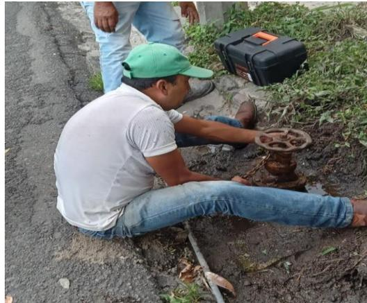
Colocación de peines para la instalación de tomas de agua potable, en viviendas de las comunidades del municipio:
