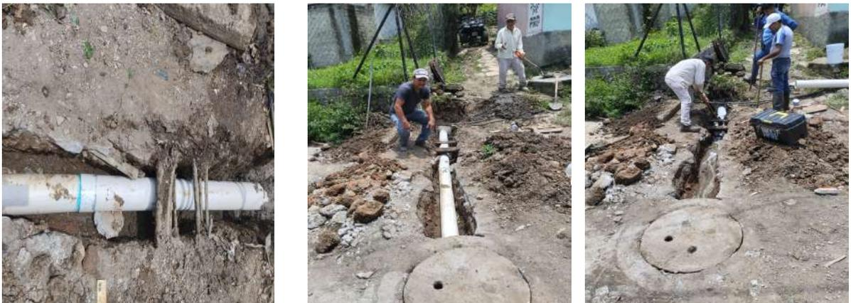
Se realizaron reparaciones en la red de agua de tres pulgadas que conduce el agua del Durazno a las Fincas.
