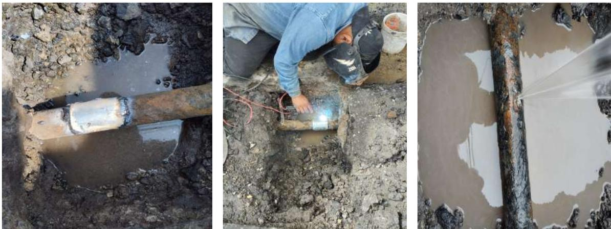
Se colocaron válvulas expulsoras de aire en la red de agua potable de la Comunidad del Salitre de la Cal para su mejor funcionamiento.
